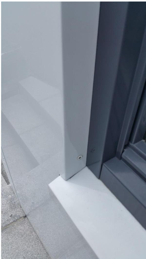
Bilde 2 & 3 : Her er det benyttet Alutile palte som såle beslag utenpå tyunnplate beslag for å få samme farge og finish på beslag og vegg.
