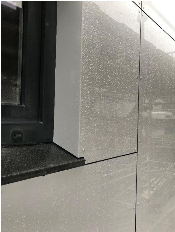
Bilde 1: Plate beslag i sort med oppbrett er satt in først. Deretter er Alutile plate montert inn med knekk inn i vindu smyg.
